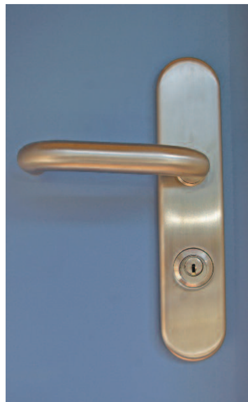
Un cylindre protégé avec une olive de sécurité, un obstacle de plus pour les cambrioleurs.
